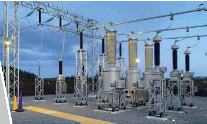
Damit Strom stets in der richtigen Stärke und Spannung fließt: Trench Messwandler im Umspannwerk.
